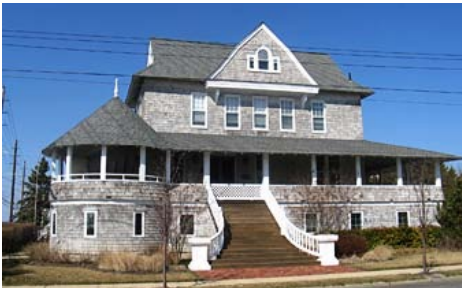
412 S. Bayview Avenue
